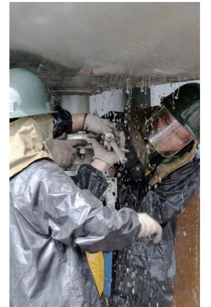
及时封堵漏点
