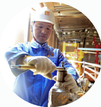
严帮银在梦溪高中压调压站开展工作
