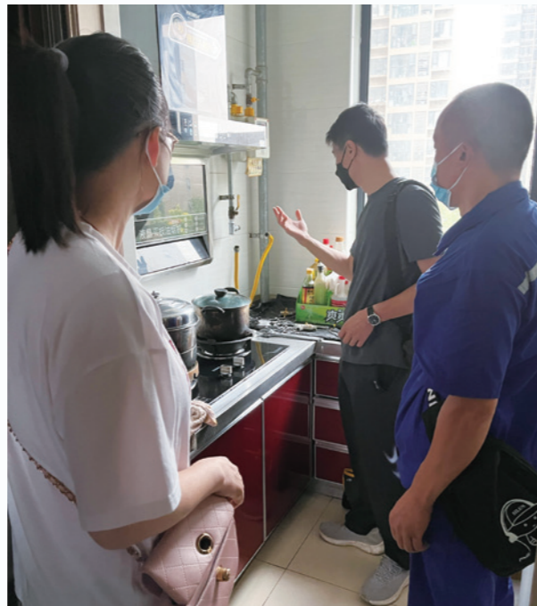
工作人员入户安装自闭阀
