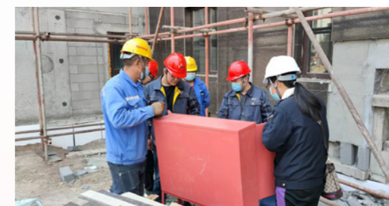
赤峰公司对施工单位各施工现场进行突袭检查
